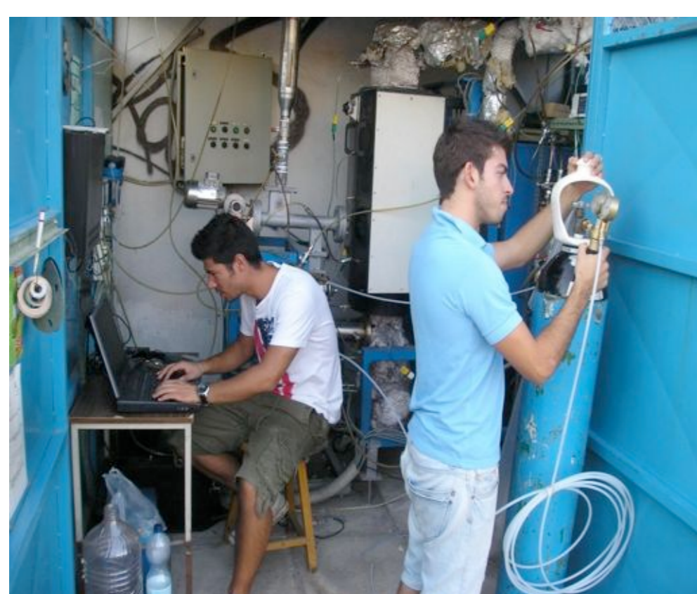
Κατασκευή πιλοτικής μονάδας
